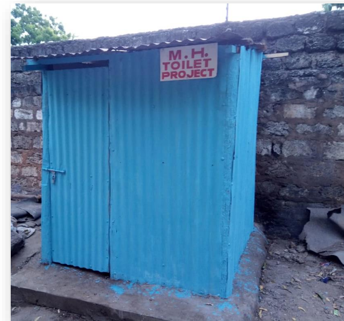
Das fertiggestellte Toilettenhäuschen für die Straßenkinder in Maboxini
