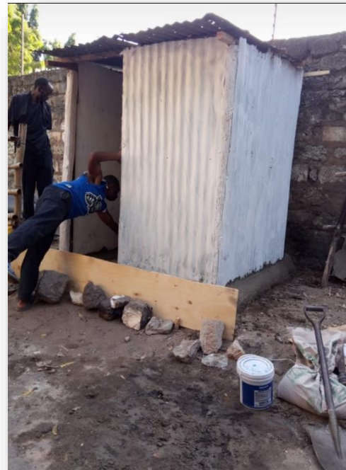
Bau der neuen Toilette
